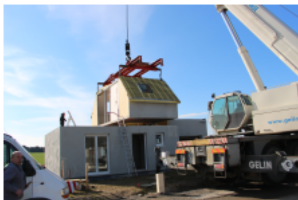
Installation des "modules" qui composent les habitations.
